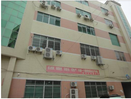
项目厂房现状
