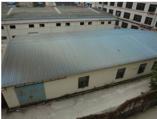
项目东面厂房
