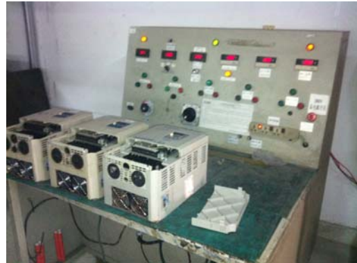
项目扩建调试设备
