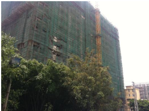
东面在建厂房
