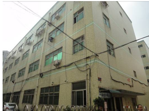
项目西面厂房
