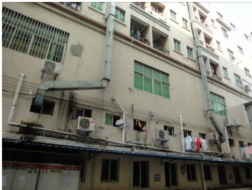
项目北面工业区宿舍
