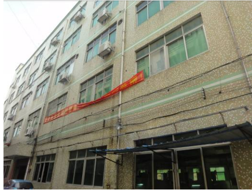
项目厂房现状
