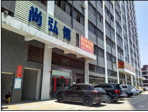
项目所在厂房现状
