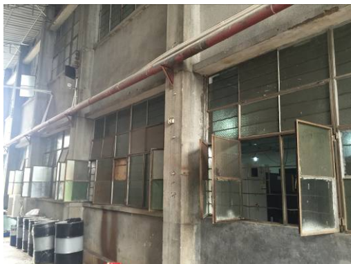
项目南面厂房
