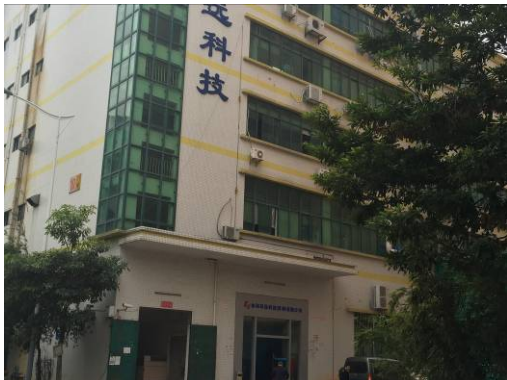
项目南面厂房
