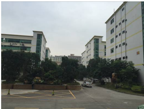
项目北面厂房
