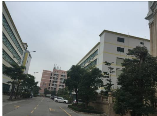
项目东面厂房
