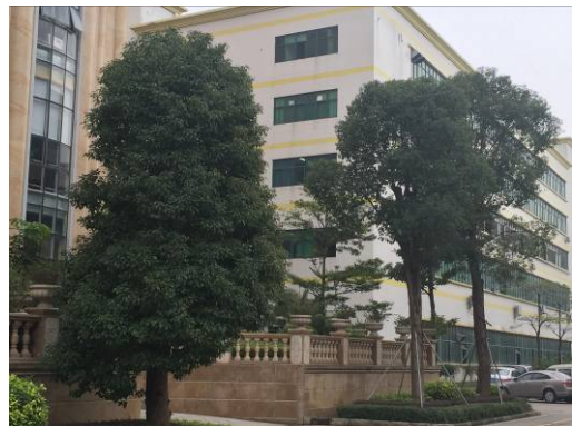
项目西面厂房
