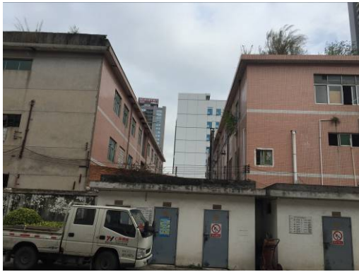
项目北面 厂房
