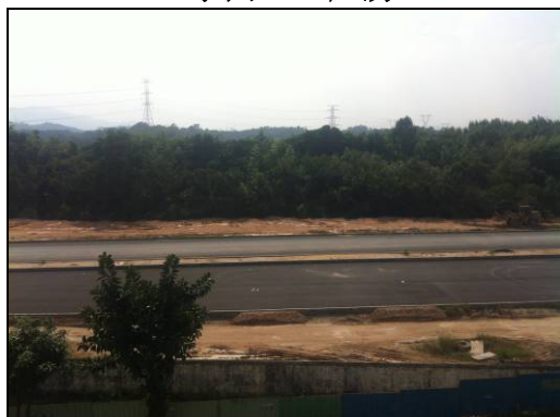
西面龙观快速路
