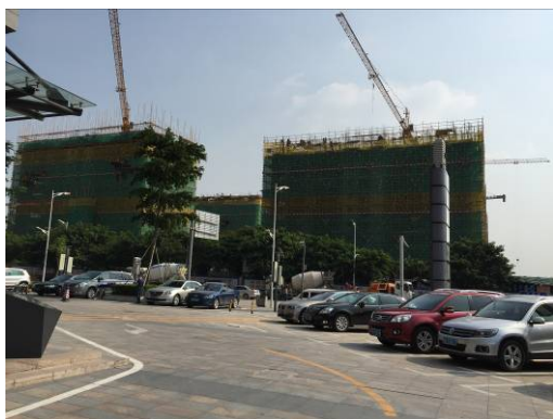
项目南面在建二期宝能园区
