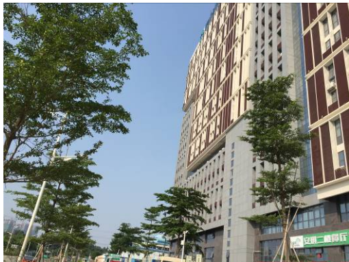
项目北面园区厂房
