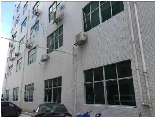
项目南面厂房
