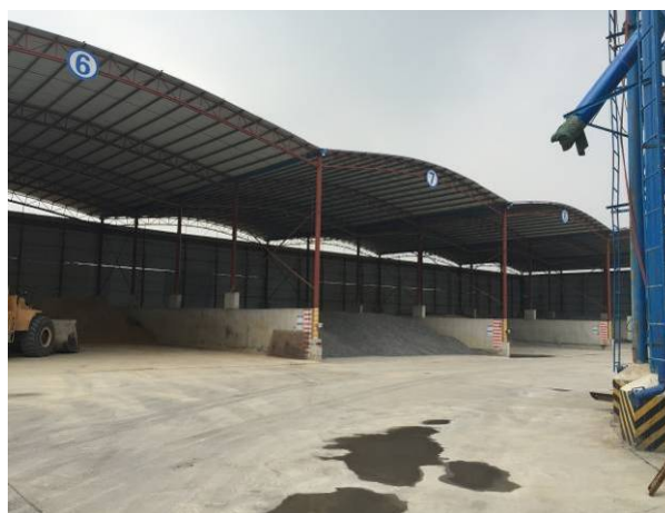
项目砂石棚存储区
