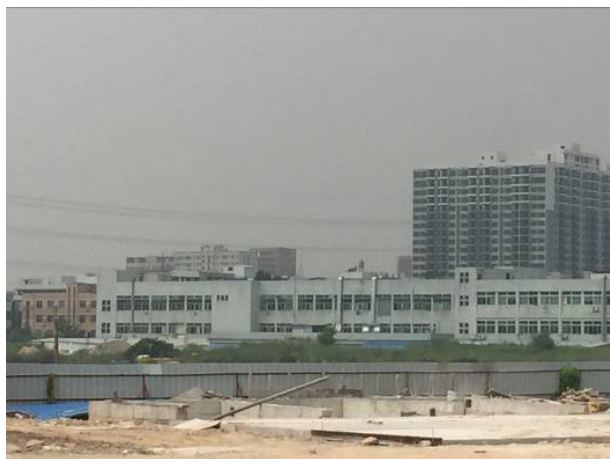
项目南面沙井泵站
