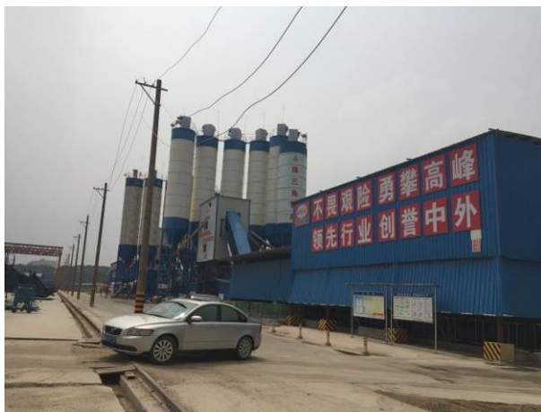
项目混凝土拌合站
