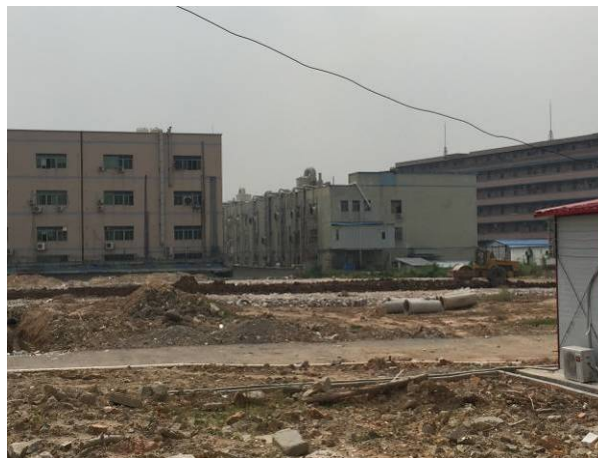
项目东面工业区厂房
