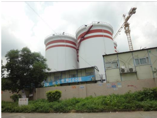
项目东面其他厂室外设备
