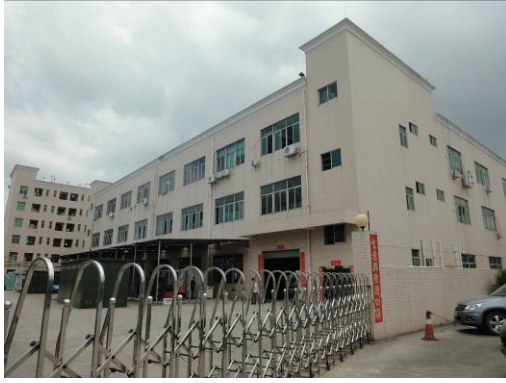
项目厂房现状
