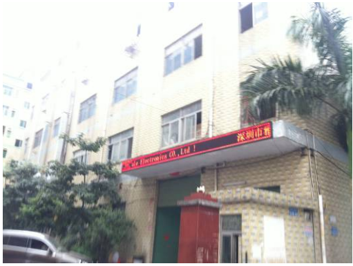
项目所在厂房外观
