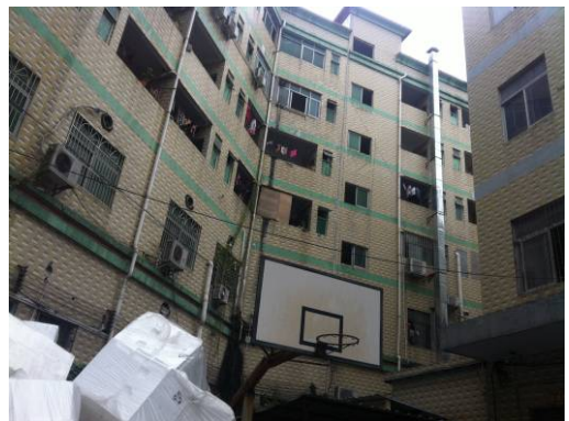
项目西面宿舍
